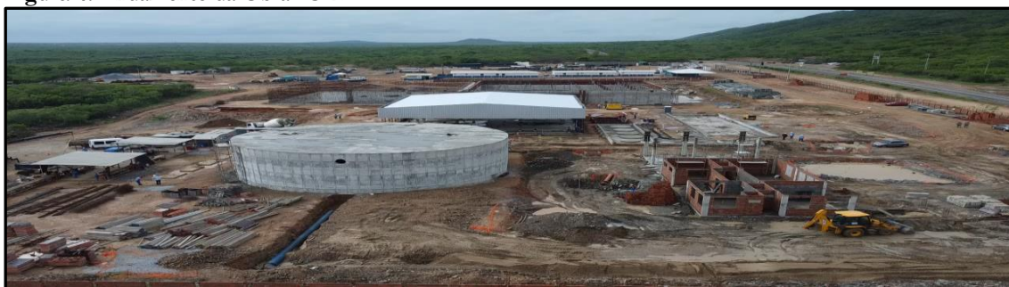
Figura 4: Andamento da Obra - SRH.
