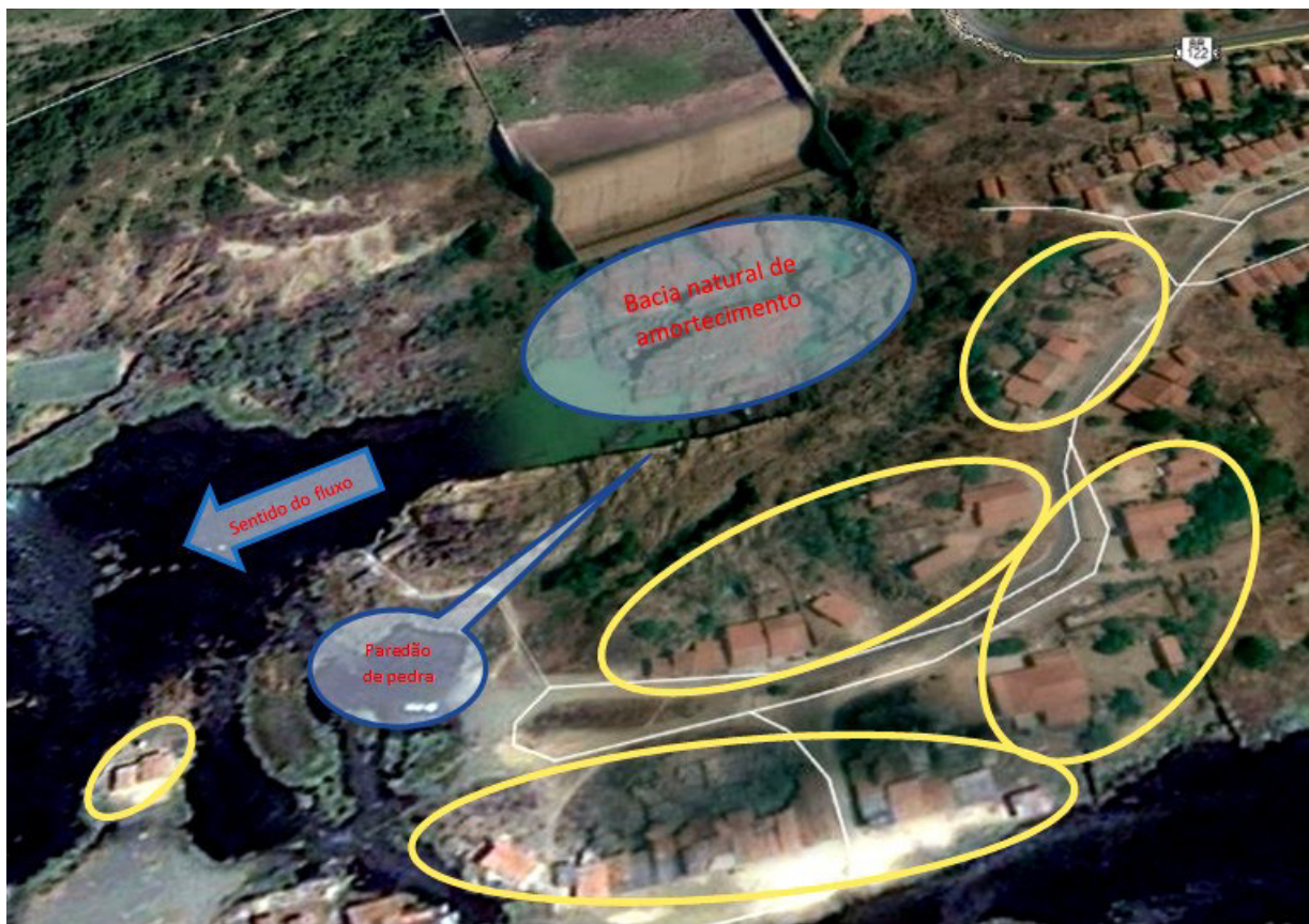
Figura 3.6 Situação do Fluxo de Água do Vertedor a jusante da Barragem
