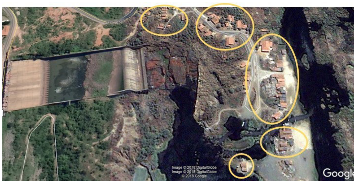
Figura 3.5 – Imagem aérea da ocupação a jusante da barragem Banabuiú
