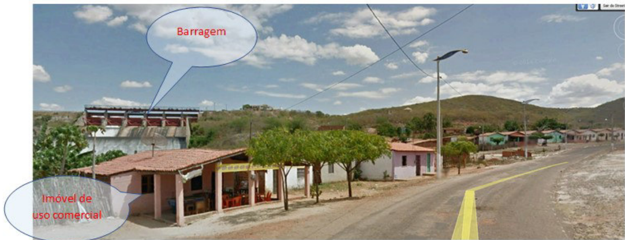
Figura 3.7 – Imagem da área da ocupação a jusante da barragem Banabuiú
