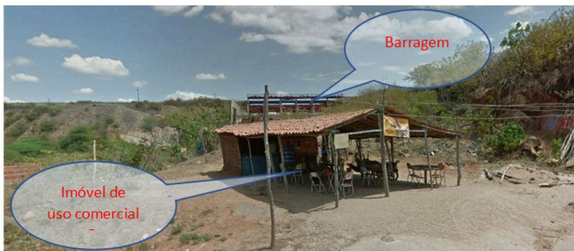
Figura 3.8 – Imagem da área da ocupação a jusante da barragem Banabuiú
