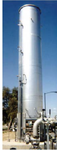
FIGURA 2 - Detalhe de um Flare Enclausurado, Flare Enclausurado instalado
